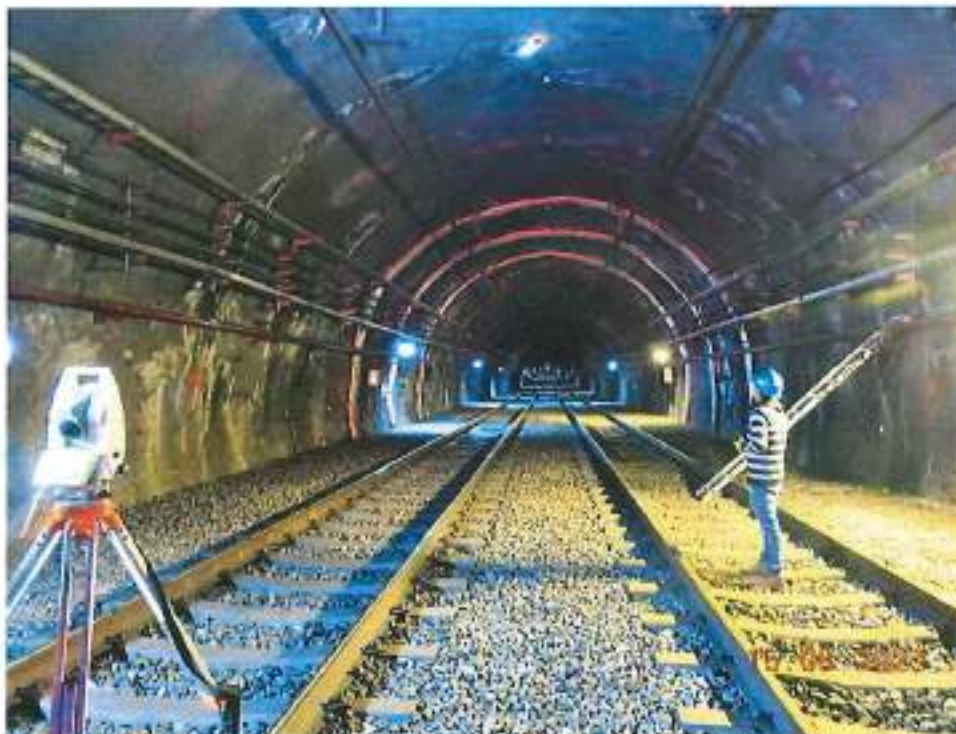
Fotografía 41. Actividades de medición con estación total de la estación de medición No. 6.
