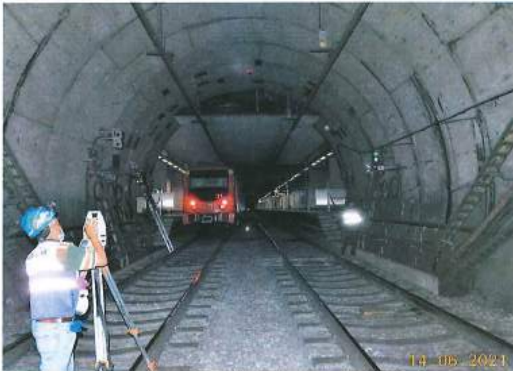
Fotografía 40. Trabajos de medición en la estación de medición No. 4.
