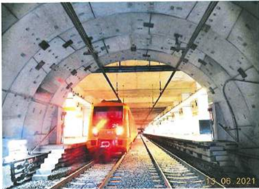
Fotografía 21. Cabecera Poniente de la estación Zapata, no presenta problemas de humedad y/o filtraciones, sólo el refuerzo de placas en la unión de dovelas.
