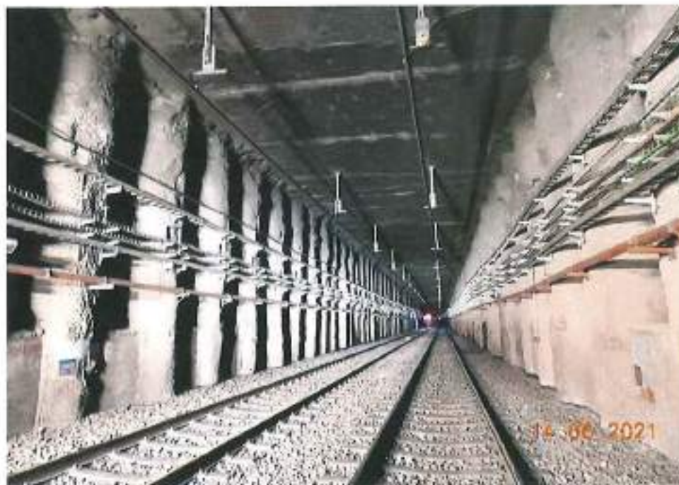
Fotografía 32. De la lumbrera Cádiz hasta la estación Mixcoac la obra subterránea fue realizada en sección cajón (como se observa en la figura a la altura del cad. 28+200.0), en dicho tramo no se aprecian problemas de humedad y/o filtraciones de agua de consideración.
