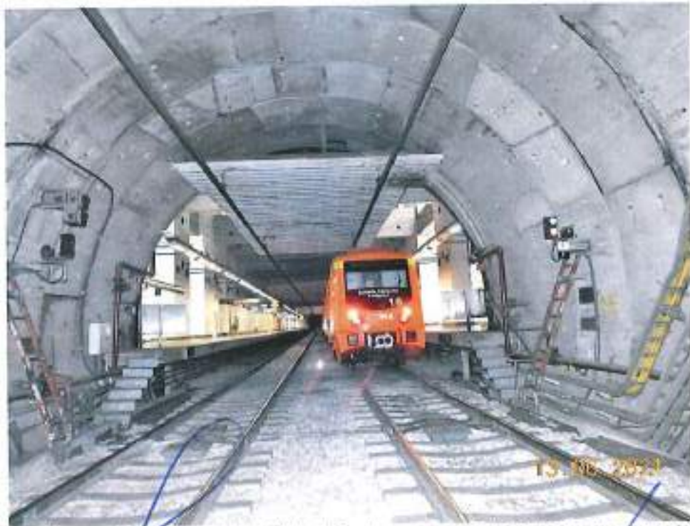
Fotografía 25. Cabecera Oriente de la estación 20 de Noviembre, no presenta problemas de humedad y/o filtraciones actuales, se encuentra al día de la visita seca.
