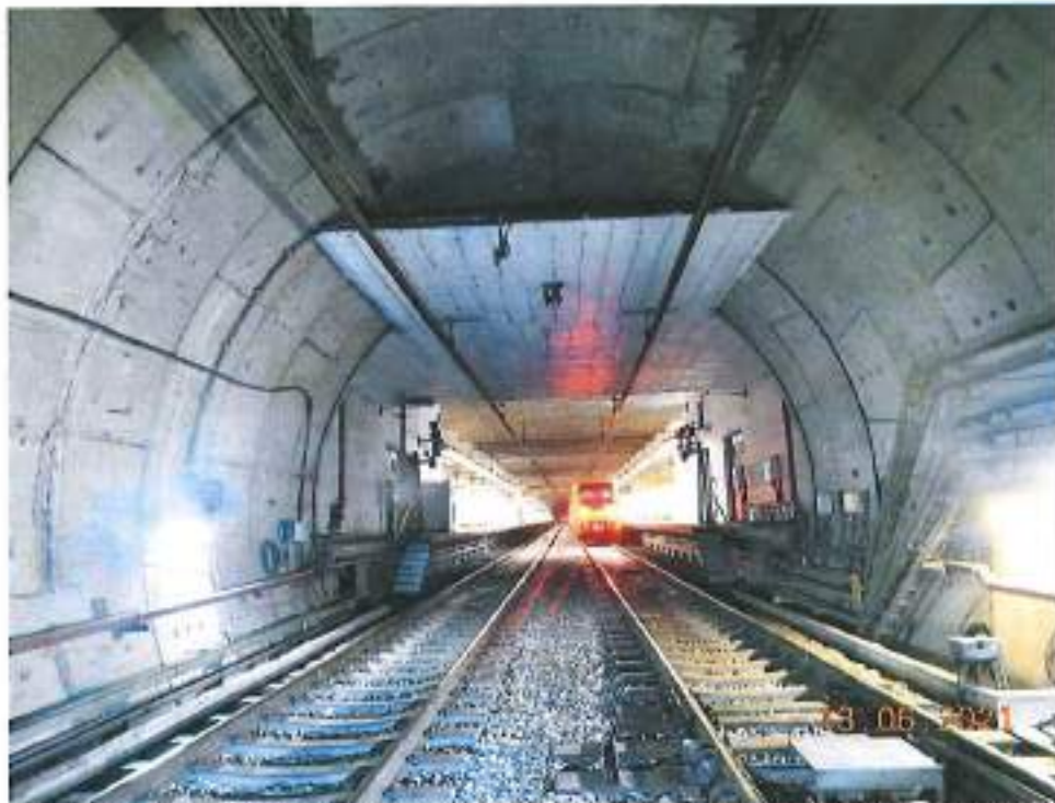
Fotografía 22. Cabecera Oriente de la estación Zapata, no presenta problemas de humedad y/o filtraciones actuales, se encuentra al día de la visita seca.
