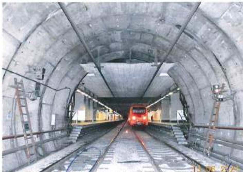
Fotografía 15. Cabecera Poniente de la estación Eje Central, donde no existen afectaciones de consideración por filtraciones y/o daños estructurales visibles.
