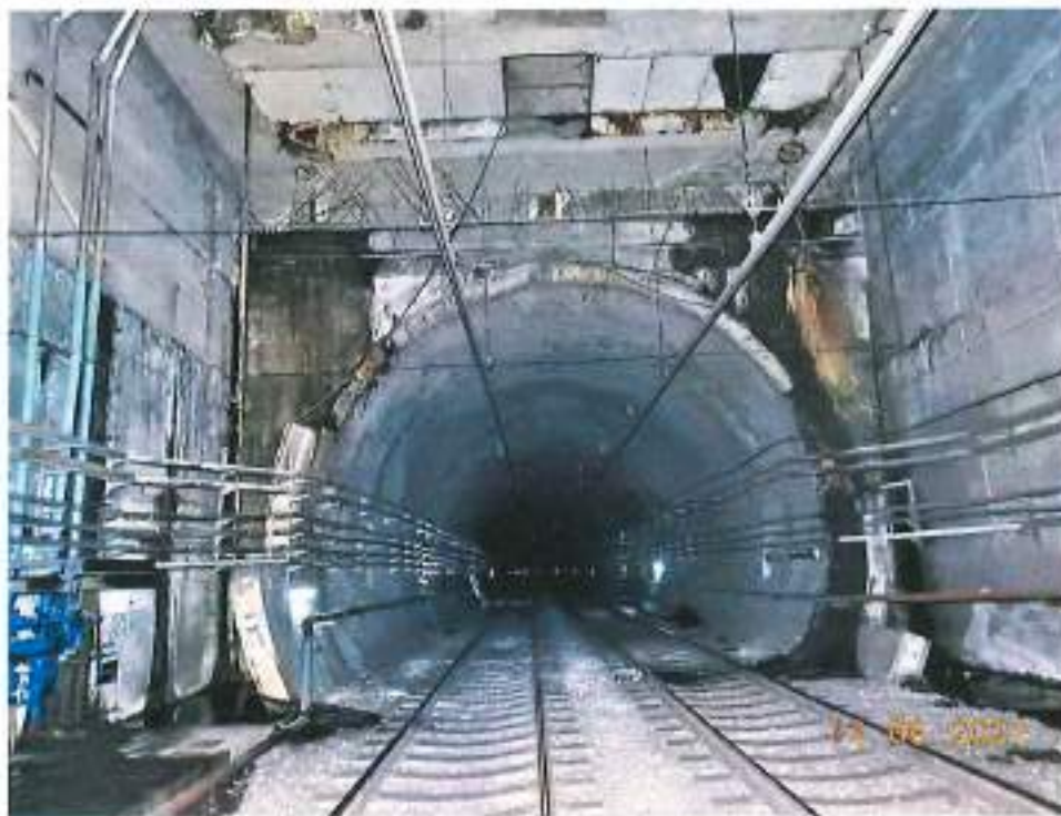
Fotografía 1. Vista del inicio del túnel con dovelas [cad. 20+340.0]
