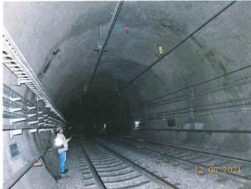
Fotografía 2. Túnel con dovelas recubiertas con concreto lanzado a la altura del cad. 20+443.30, vista dirección Mixcoac.
