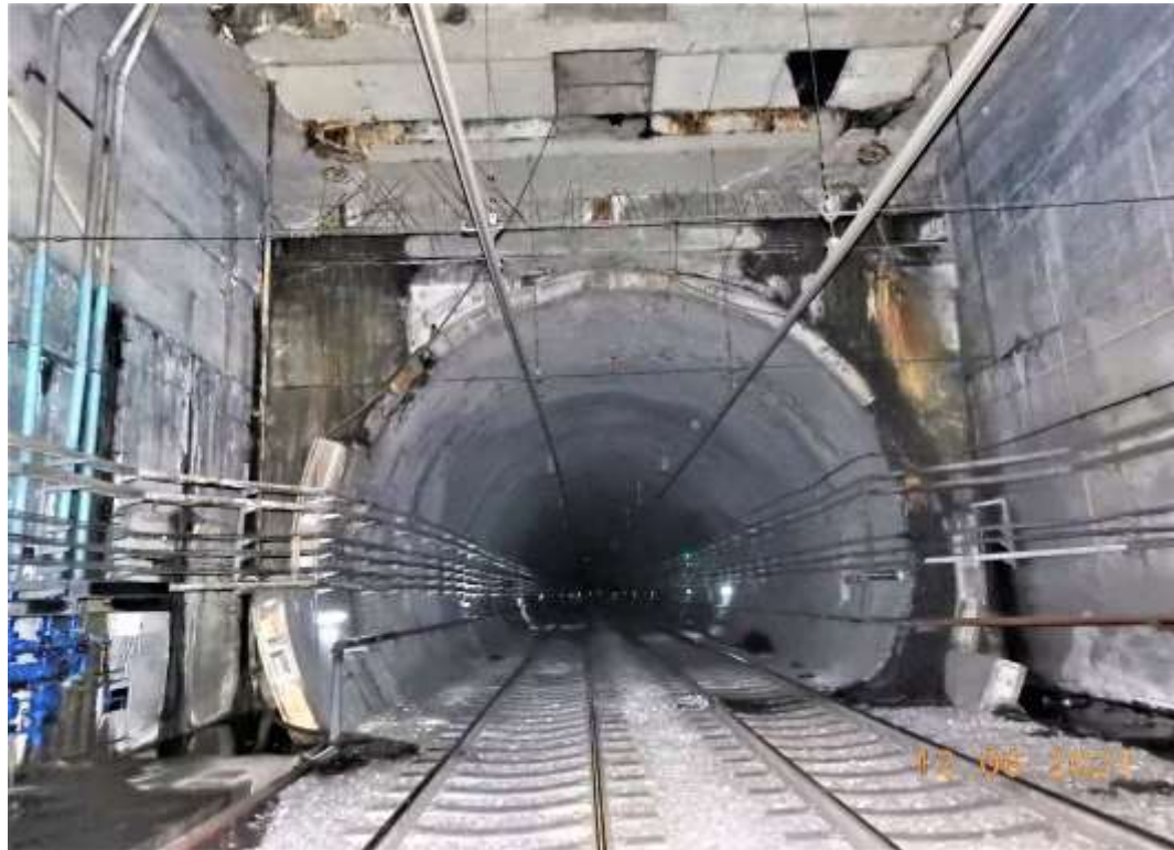
Transición de sección en cajón a inicio del túnel con dovelas
