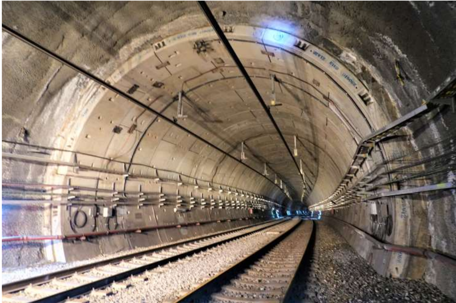
Transición de túnel construido con tuneladora (dovelas) y el construido con método convencional.
