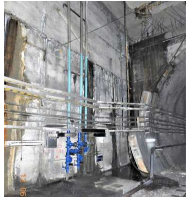
Transición de sección en cajón a inicio del túnel con dovelas
