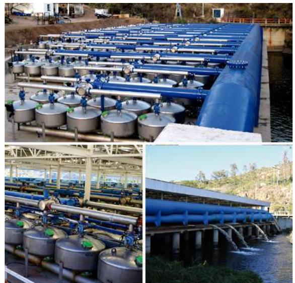
Figura 4. Plataforma de filtrado.
