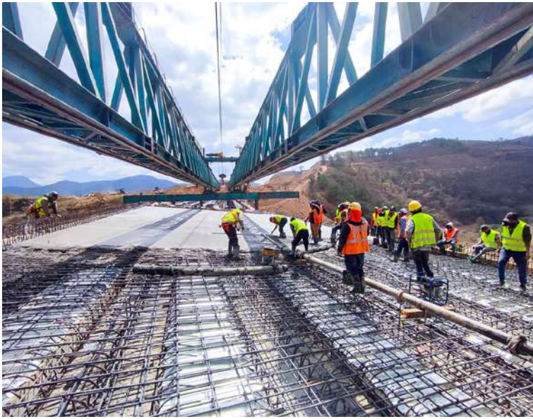
Labores de construcción del puente El Nopal.
