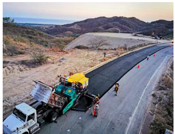
Tendido de mezcla asfáltica.
