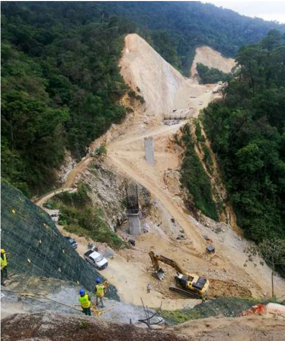
Construcción de apoyos del Viaducto Oaxaca.
