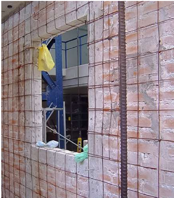
Figura 4. Muro rehabilitado con malla (Flores et al. 2004).
